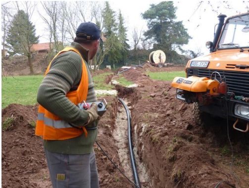
13 Kilometer Rohrleitungen verlegt. Foto: Nahwärme Schönstadt eG
