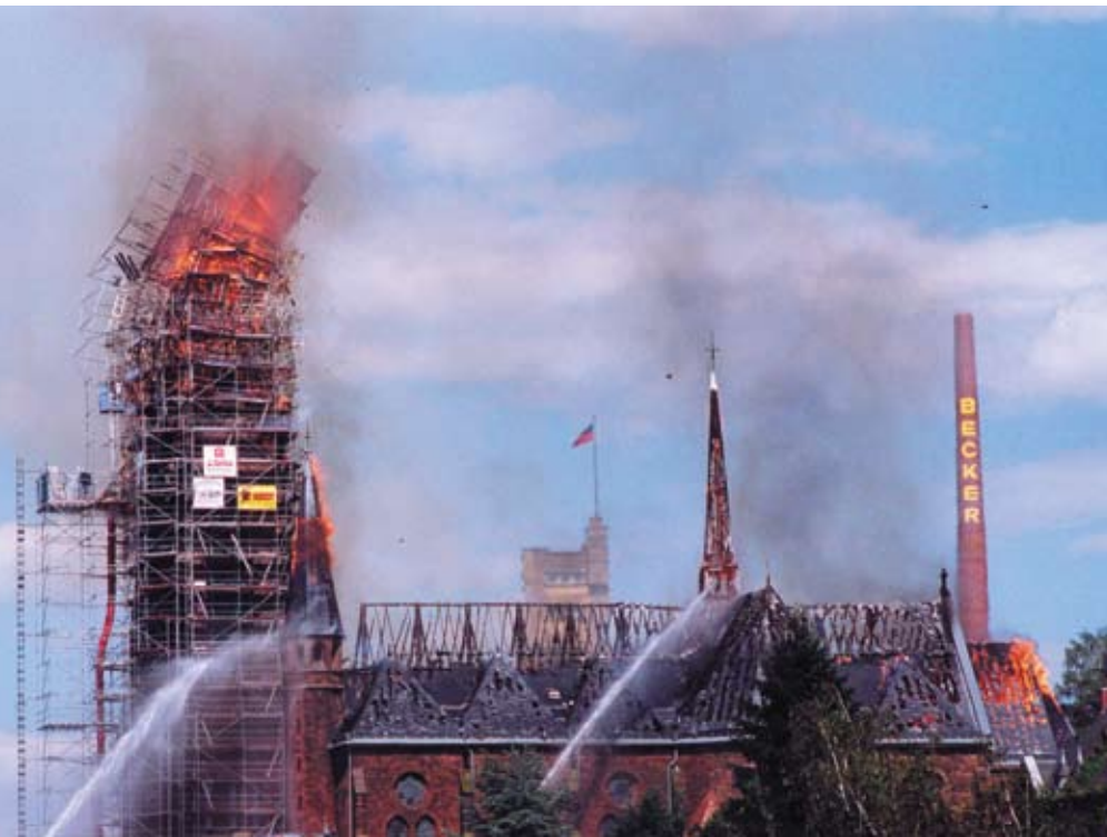
Ein Feuer zerstörte im Juli 2007 den Dachstuhl der Kirche in Sankt Ingbert. Über ein Sozialaufgeld, das die 1. Sankt Ingberter Bürger-Solar-Genossenschaft erhebt, wird die Sanierung mitgetragen.
